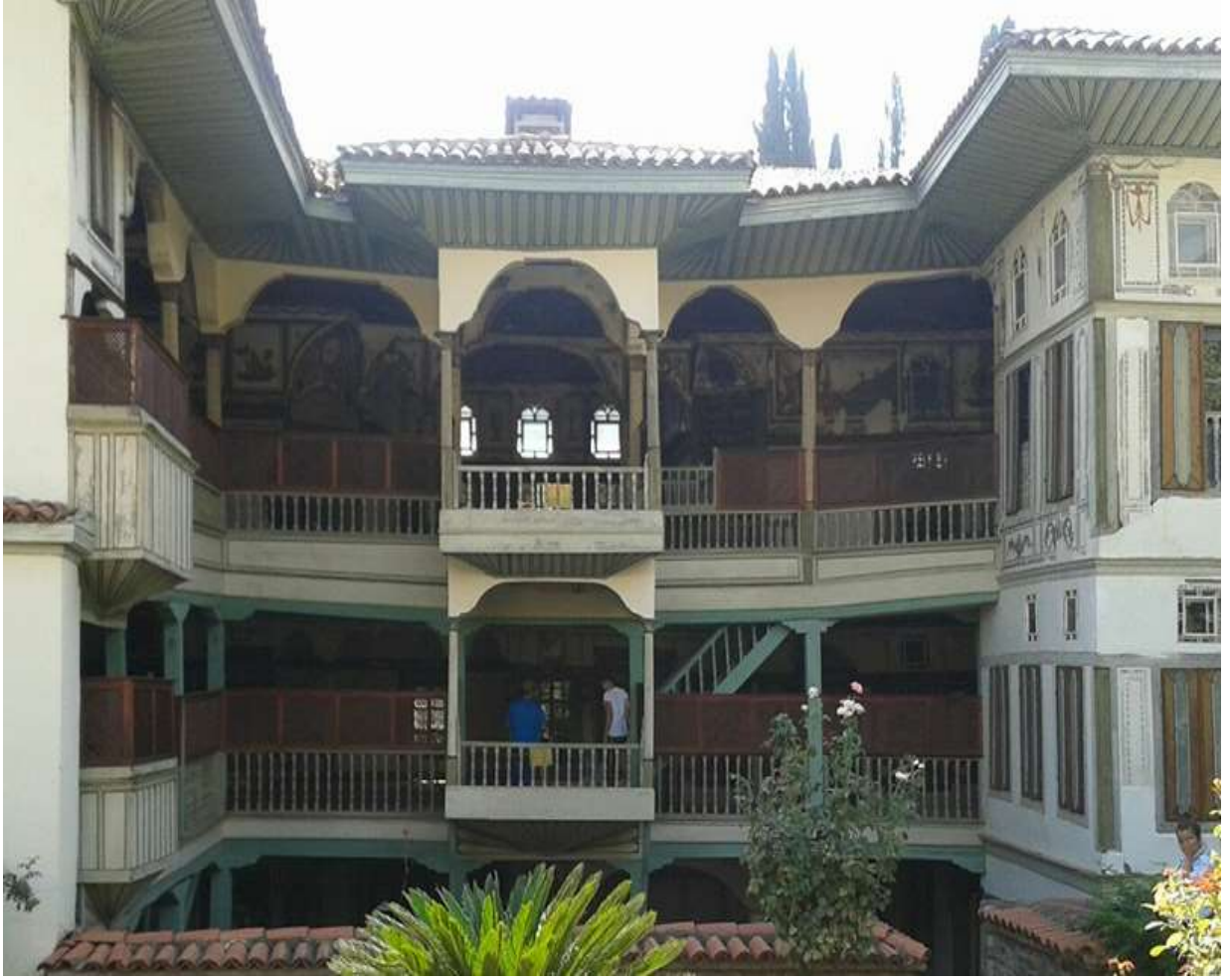
Resim1. Çakırağa Konağı, Birgi Dış Mekân: Ön Cephe–Giriş ve Avlu
