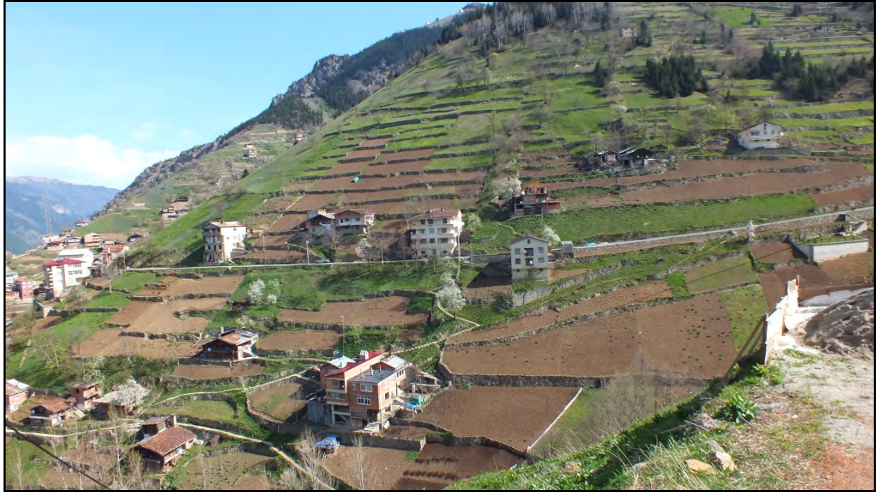
Şekil: Karaçam Deresi Havzası'nda duvar setlerle erozyonu önleme çalışmaları.
