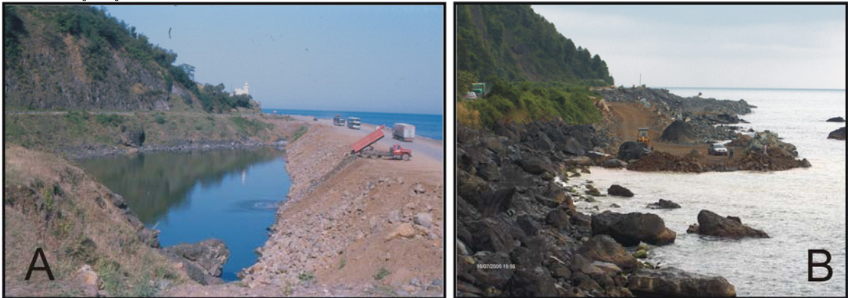
Foto 3 a-b: Denizel kıyıda yapılan dolgular ile yol platformu için yer kazanılması.
