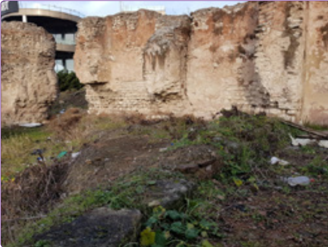
Şekil 7. İç mekânı bölen duvar kalıntısı (Altuğ, 2020).
