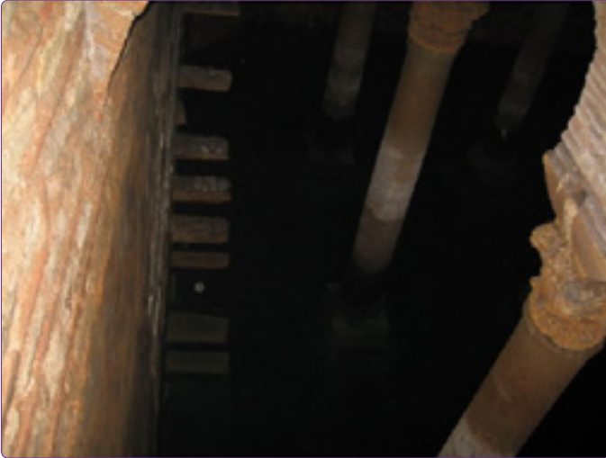
Şekil 21. Sarnıç içine inen merdiven örnekleri (Altuğ, 2013).
