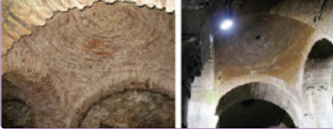
Şekil 15. İstanbul sarnıçlarından yelken tonoz örnekleri [Şeyh Murat Mescidi yakınındaki sarnıç ve Eşrefiye Sarnıcı] (Altuğ, 2013).
