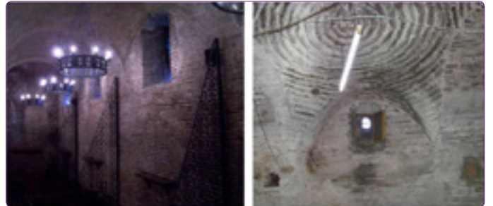
Şekil 19. Soğukçeşme Sokağı Sarnıcı ile İbadethane Sokağı'nda bulunan sarnıçta havalandırma pencereleri (Altuğ, 2013).
