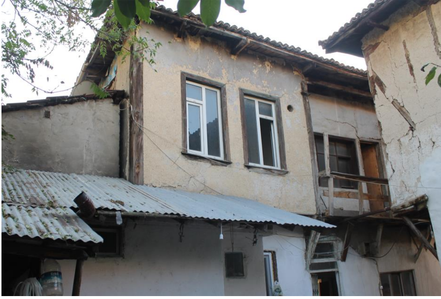
Şekil 14: Yapıya sonradan eklenen balkon, 2016 (GTÜ Restorasyon Arşivi).
