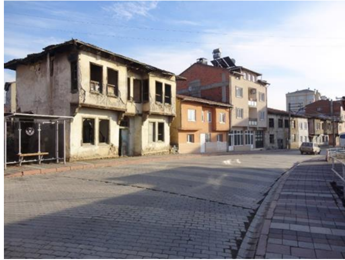
Şekil 6: Remzi Bey Konağı ve ek yapıları ile sonlanan yapı sırası (Güneş Kaya Arşivi, 2017).
