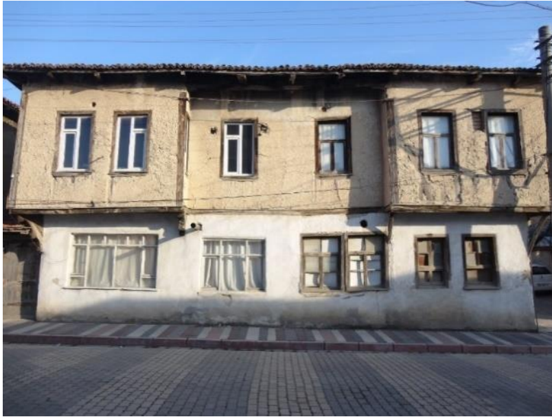
Şekil 17: Remzi Bey Konağı'nın batı cephesi (Güneş Kaya Arşivi, 2017).
