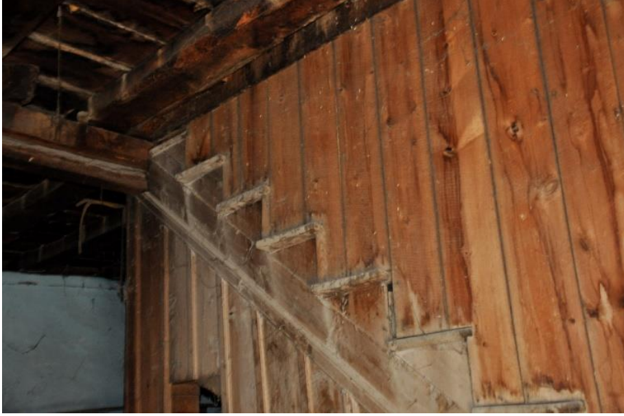
Şekil 12: Bölücü duvar içinde kalan özgün merdiven (GTÜ Restorasyon Arşivi, 2016).
