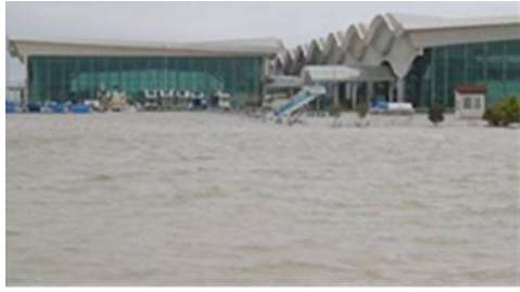
Foto 2. Kurutulmuş Amik Gölü'nün sahası içinde inşa edilen Hatay havalanında yükselen sular, hava trafiğine kapanmasına neden olmuştur (Mart 2012).
