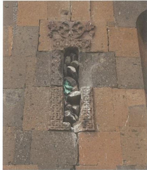
Res. 10 Kızıl Kilise, doğu cephe, pencere (2007).
