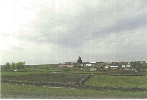
Res. 1 Kızıl Kilise, kuzeydoğudan genel görünüş (2007).
