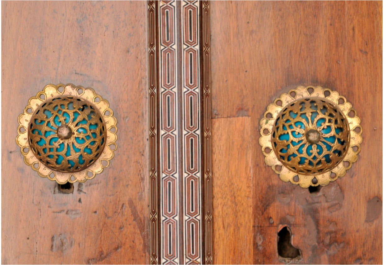
Foto 4: III. Murat Türbesi kapı kanatları üzerindeki ajurlu madeni kabaraların içindeki firuze sırlı kabaralar (Demirsar Arlı)
