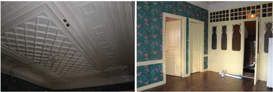
G. 6: Sunazırı Sokağı Köşkü Zemin Kat Sofasının Tavanı ve Bölücü Doğramaları (GTÜ Restorasyon A.B.D. Arşivi, 2018).
