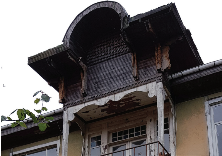
G. 17: Şekerpare Sokağı Köşkü Alınlığı (Z. S. Güneş Kaya Arşivi, 2019).
