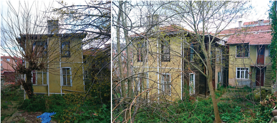
G. 18: Şekerpare Sokağı Köşkü Batı ve Güney Cephesi Fotoğrafları (C. Balcan Arşivi, 2020).
