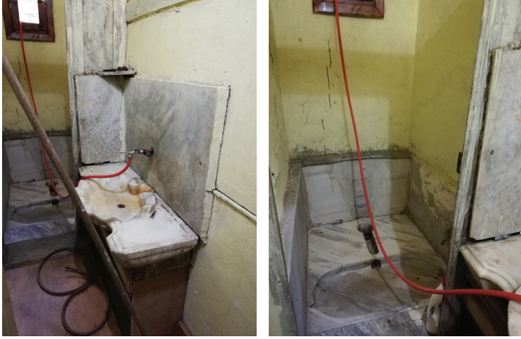
G. 9: Sunazırı Sokağı Köşkü Zemin Kat Özgün Helâ Tefrişleri (GTÜ Restorasyon A.B.D. Arşivi, 2018).
