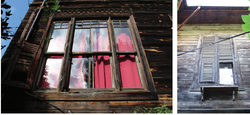
G. 7: Sunazırı Sokağı Köşkü Giyotin Pencere ve Ahşap Kepenk Örnekleri (GTÜ Restorasyon A.B.D. Arşivi, 2018).
