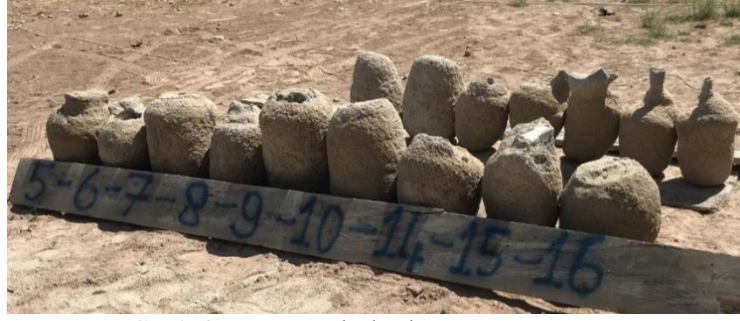
Şekil 3. Jet grout kolonlarının görünümü.
