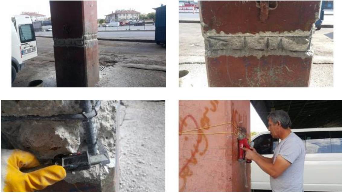
Şekil5. Taşıyıcı betonarme kolonlarda gerçekleştirilen donatı tespit çalışması
