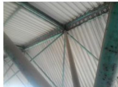
Şekil 8. Taşıyıcı boru kesitli elemanlarda yapılan kesit ölçümleri ve oluşan hasarlar
