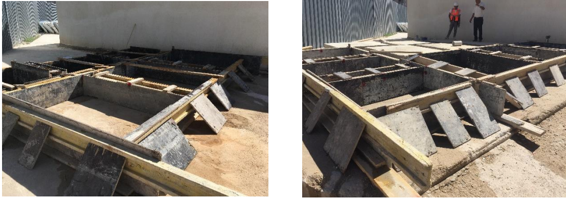
Şekil 3. C10 ve C30 Beton Kalıplarının Hazırlanması
