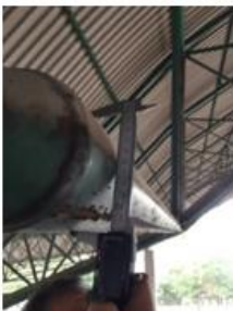
Şekil 8. Taşıyıcı boru kesitli elemanlarda yapılan kesit ölçümleri ve oluşan hasarlar
