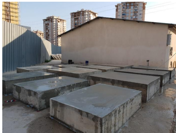
Şekil 5. Betonların Sulanması
