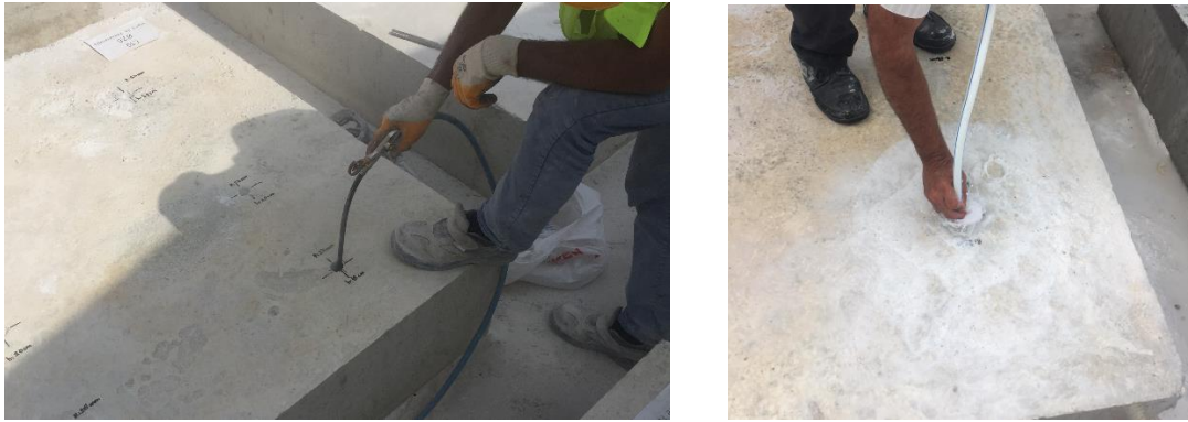
Şekil 7. Açılan Deliklerin Hava ve Su ile Temizlenmesi
