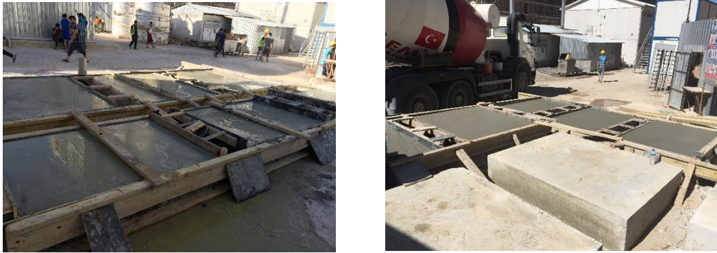
Şekil 4. C10 ve C30 Beton Dökümü
