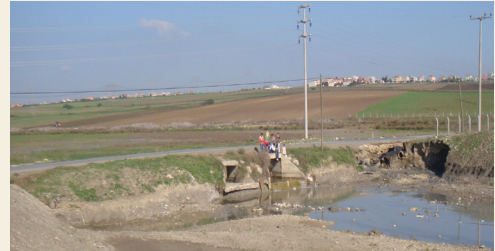
Foto 1-2: Silivri-Celaliye arasındaki vadileri enlemesine geçen yollara ait yol dolguları ve yüzeysel akış için bırakılan menfezler.
