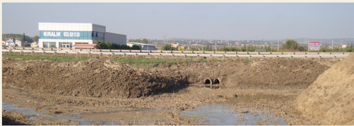
Foto 1-2: Silivri-Celaliye arasındaki vadileri enlemesine geçen yollara ait yol dolguları ve yüzeysel akış için bırakılan menfezler.
