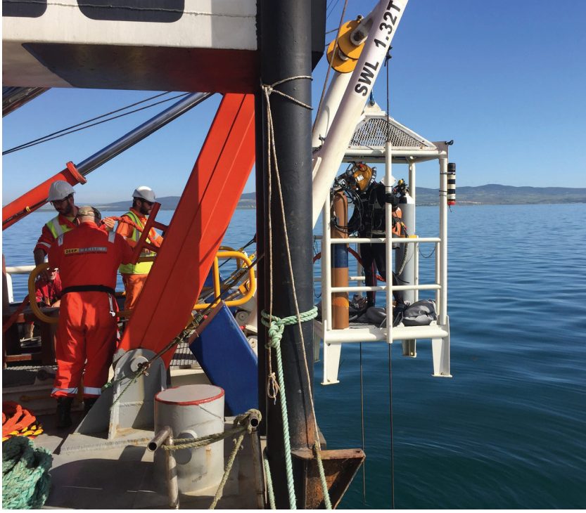
Resim 2: Tüm dalgışlar dalgış sepeti (stage) ile yapıldı.
