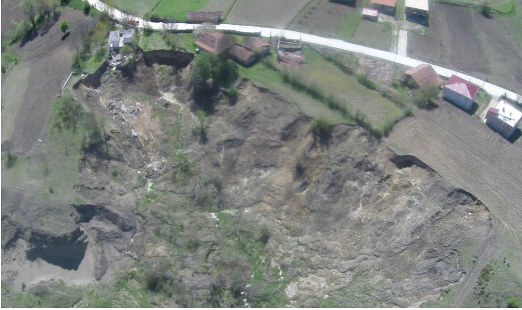
Fotoğraf 7. Ladik İlçesi Teberoğlu Mahallesi Heyelan Gözlem Noktası (40.984154°K, 35.807325°D)
